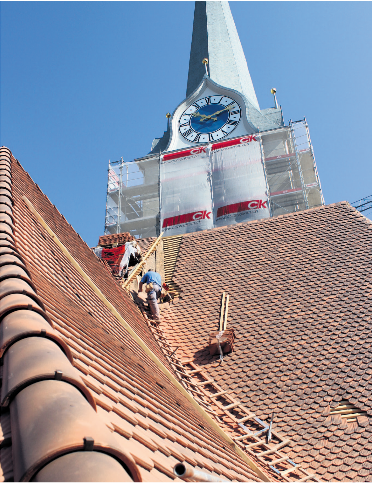
Ein Arbeiter der Dachdeckerfirma Karl Rölli AG ist mit dem Ausbau einer Ziegelkehle beschäftigt. Fotos Pascal Vogel
