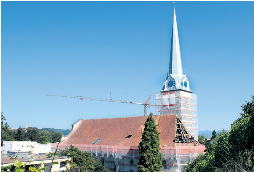
Die letzten Dachdeckerarbeiten sind im Gange: Auf das über 200-jährige Gebälk wurden mehrere Hundert Liter Wurmenschutzmittel aufgetragen.
