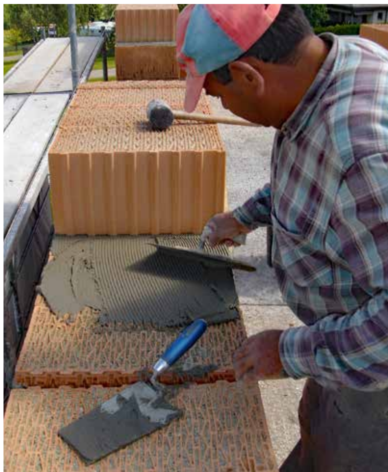
Hidden Champion: seine Vorteile spielt der Backstein auch aus, wenn er verputzt wird. Wärmedämmende Grossblocksteine werden im Läuferverband in den Mauerstärken 30/36.5/42.5 und 49 cm aufgemauert. In einer verputzten Fassadenkonstruktion sind damit die Tragfähigkeit, die Wärmedämmung und -speicherung sowie der Witterungsschutz vereint.
