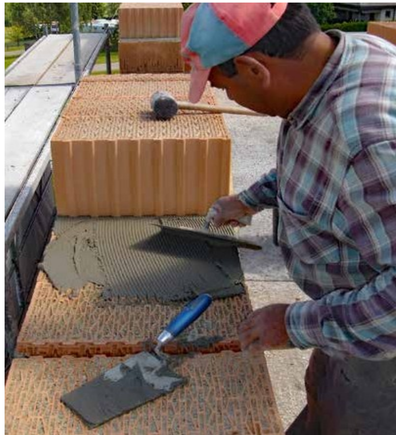
Hidden champion : la brique présente aussi des avantages lorsqu'elle est enduite. Les grandes briques isolantes sont maçonnées en appareil de paneresses dans les épaisseurs de mur 30/36.5/42.5 et 49 cm. Dans une construction enduite en façade, la portée, l'isolation et le stockage thermique ainsi que la protection contre les intempéries sont ainsi réunies.
