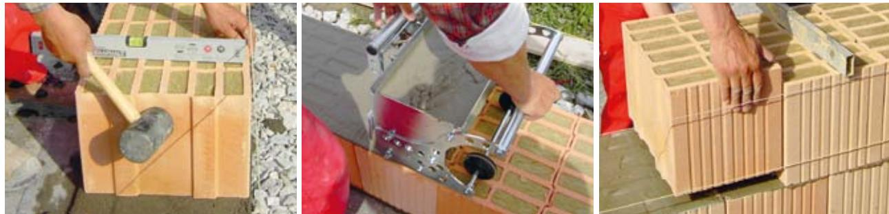
Les briques ThermoCellit-Top ont des faces de pose rectifiées, ce qui permet la pose au mortier-colle distribué par un rouleau. Ce système éprouvé, dont la mise en œuvre est la plus rapide, permet d'économiser du temps et de la matière.
