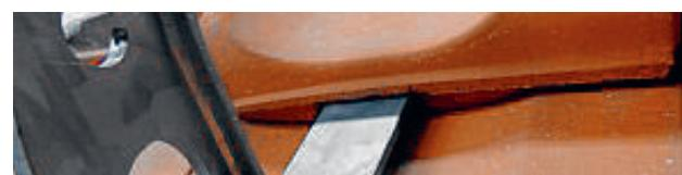
Le crochet de sécurité SH AGZ ne doit pas nécessairement être au centre de la tuile.
