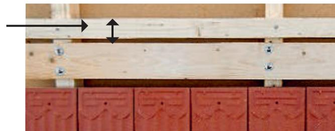
**Important:** Le trou de vis supérieur doit être exact sur le centre-lattage.
