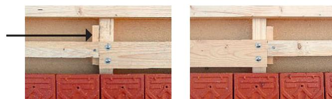
**Important:** Le trou de vis supérieur doit être exact sur le centre-lattage. En cas de pénétration des vis dans la sous-toiture, celle-ci doit être étanche conformément à la norme SIA 232/1 (chiffre 2.2.10.3).
