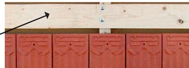
**Important:** La latte est coupée jusqu'à la bordure extérieure du contre-lattage. Par ailleurs, un morceau de lattage est cloué latéralement dans la contre-latte à env. 20 cm.
