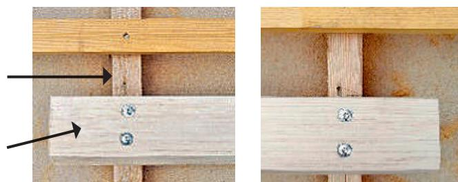
Une vis TBS est placée en diagonale par le bas dans la face frontale de la chanlatte conique, à l'endroit où est monté le crochet de sécurité SH AGZ.
