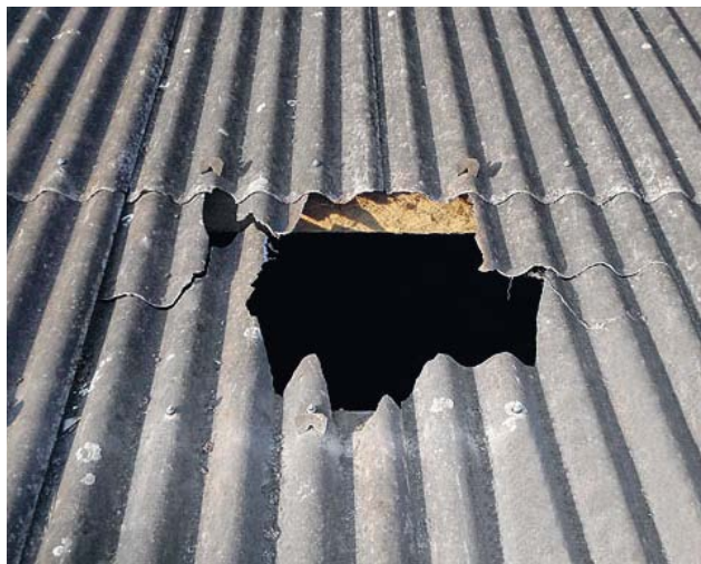
Rupture de panneaux en fibrociment ondulés
